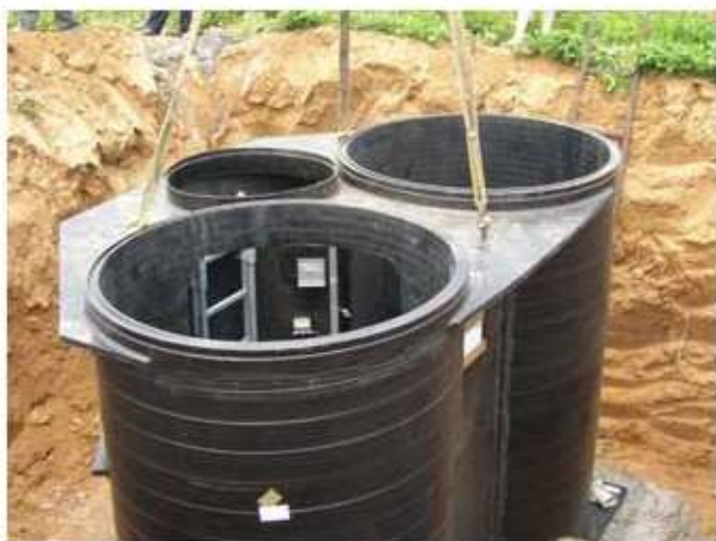
PE-HD лизиметрическая станция на 2 лизиметра во время и после установки в городе Шихия/ Китай
