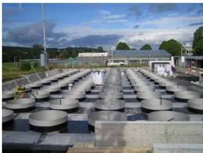
Большая лизиметрическая станция с бетонным коробом на 72 лизиметра в Цюрихе-Рекенхольц
