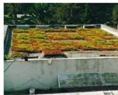
«Зеленая» крыша с крышевым лизиметром на переднем плане
