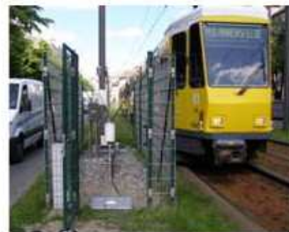
«Зеленое» полотно железнодорожного пути с лизиметром
